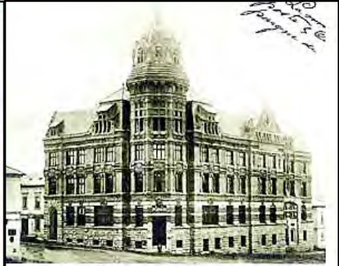
HISTORICKÉ POŠTOVNÍ BUDOVY NOVÝ BOR, NÁM. MÍRU 55
