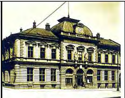
HISTORICKÉ POŠTOVNÍ BUDOVY OPAVA, MASARYKOVA TRÍDA 335/22
